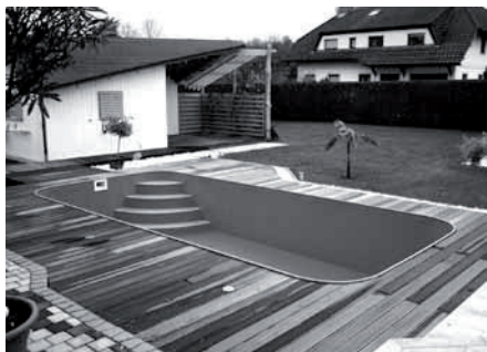
10 Zapuštěný laminátový bazén s okolní plochou z dřevěných desek
