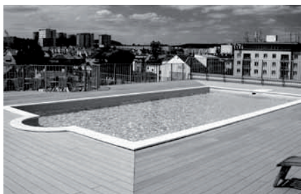
19 Bazén na střeše obytného domu Semilasso v Brně z laminátové skořepiny
