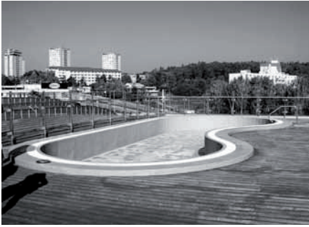
15 Bazén na střeše multifunkční budovy v Brně-Kohoutovicích
