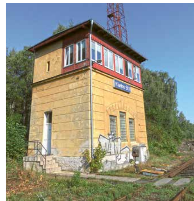
Budova stavědla v Kladně – za ní osvětlovací věž
