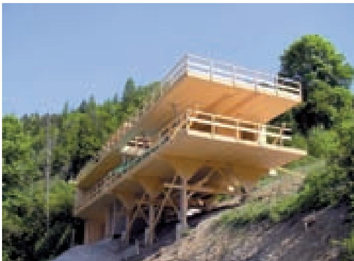
Panelový systém KLH hojně uplatňovaný v německy mluvících zemích. WOHNBÜHNE AM HANG, WEISSENBACH IM ENNSTAL Autoři: DI Ulli Koller, Ing. Thomas Stiegler; realizace: Stiegler KG, Haus i. Ennstal / KLH Massivholz GmbH, Katsch an der Mur, Rakousko
