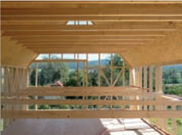
Příklad dřevěné sloupkové konstrukce vycházející z tradic systému „two by four“
