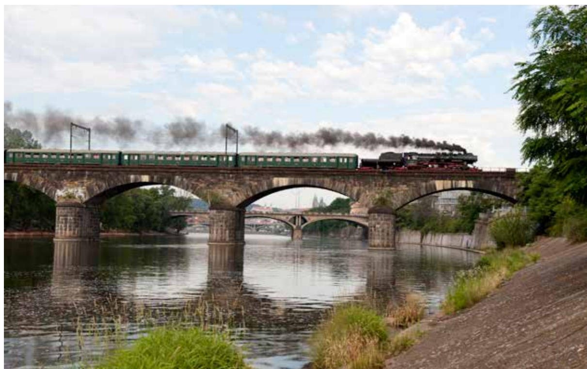
Souprava historických vozů Bai na Negrelliho viaduktu, tažená historickou lokomotivou řady 52 – foto: Vladimír Fišar
