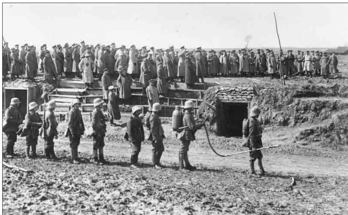
Lehké plamenomety obsluhovali dva vojáci – jeden nesl nádrž s hořlavinou a stlačeným dusíkem, druhý nesl hadici. První typy se zapalovaly ručně, což se ukázalo být nebezpečné, pozdější verze měly automatický zapalovací systém. (IWM, Q44155)
