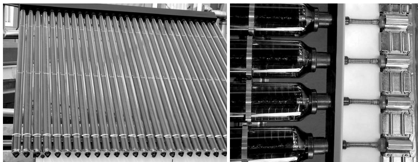
19 Trubicový vakuový kolektor
