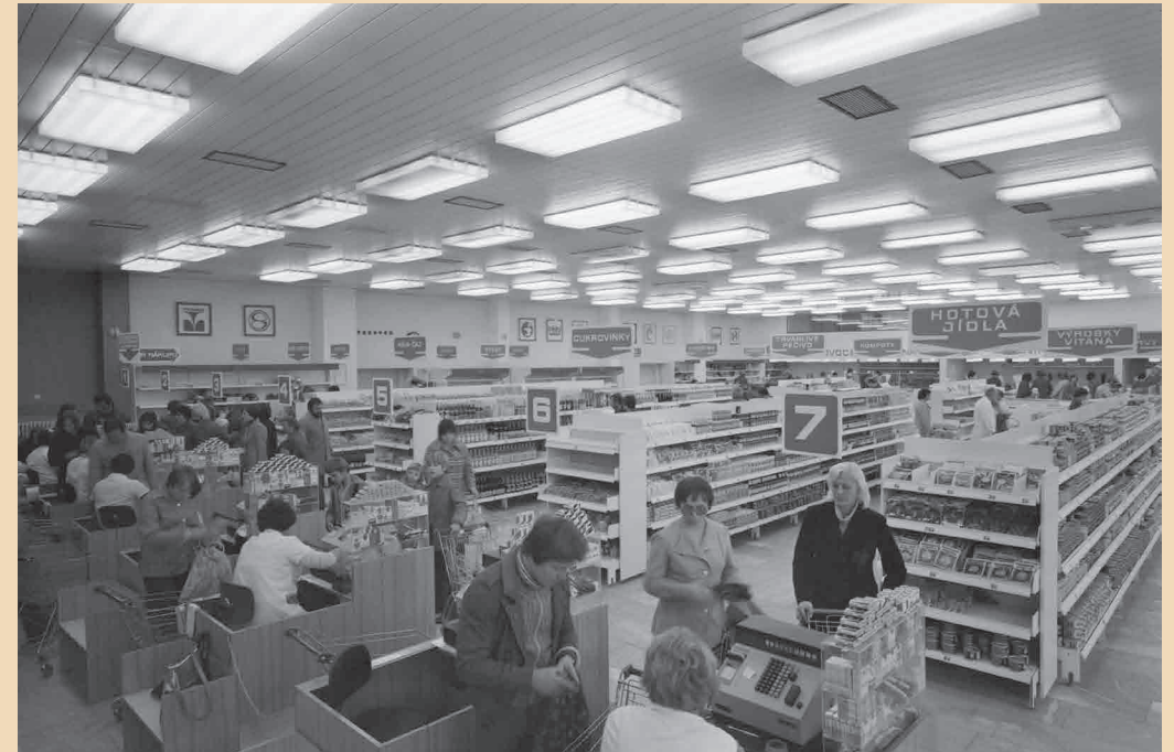
Samoobslužná prodejna Odra v Ostravě Výškovicích.
