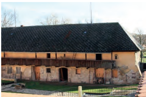
Původně pozdně gotický statek v Neprobylicích na Slánsku
