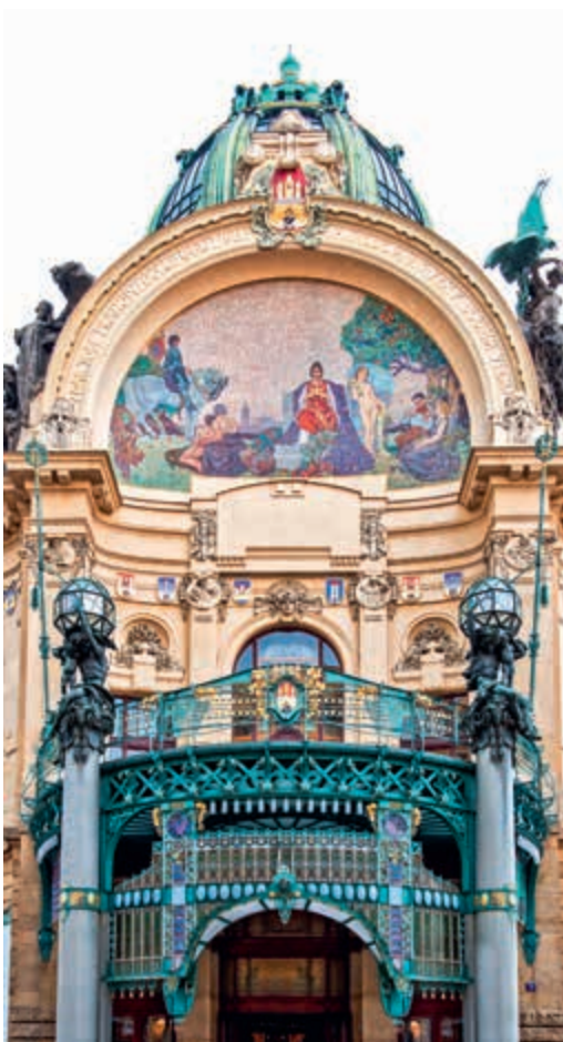
Detail Obecního domu
