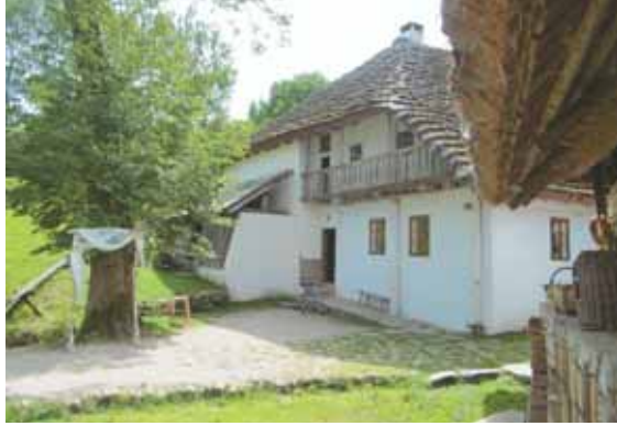
Ještě v roce 2004 byl mlýn ve špatném stavu, po opravě vypadá velmi dobře.
