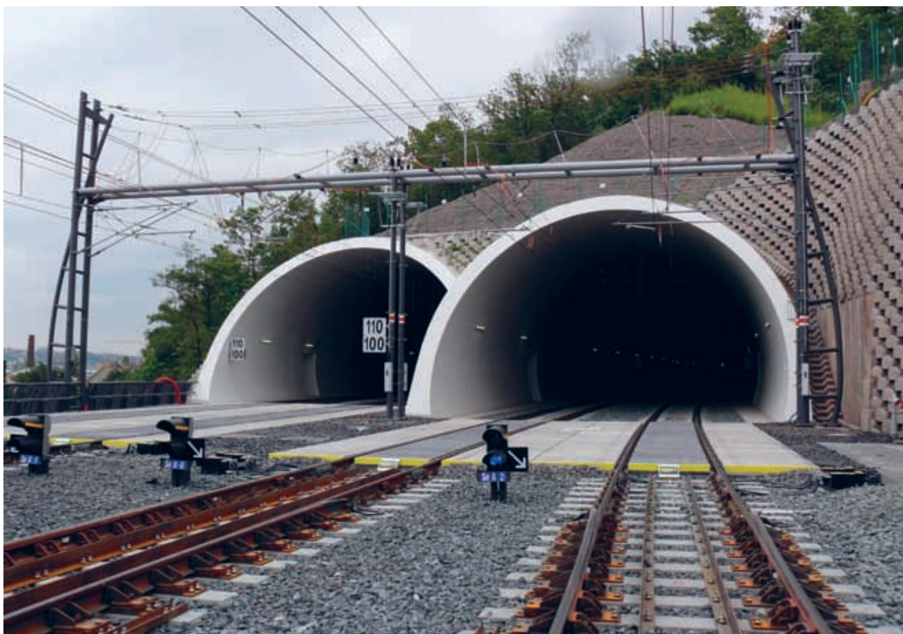
Portál tunelů Nového spojení od hlavního nádraží
