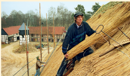
Rákos je (nebo spíše býval) s oblibou používán jako stavební materiál pro pokrývání střech.
