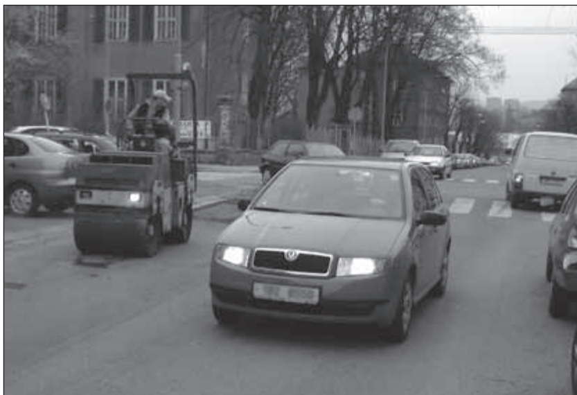
V tomto případě musí řidiči poslechnout pokyn k zastavení k zastavení zaměstnance, provádějícího opravu vozovky.
