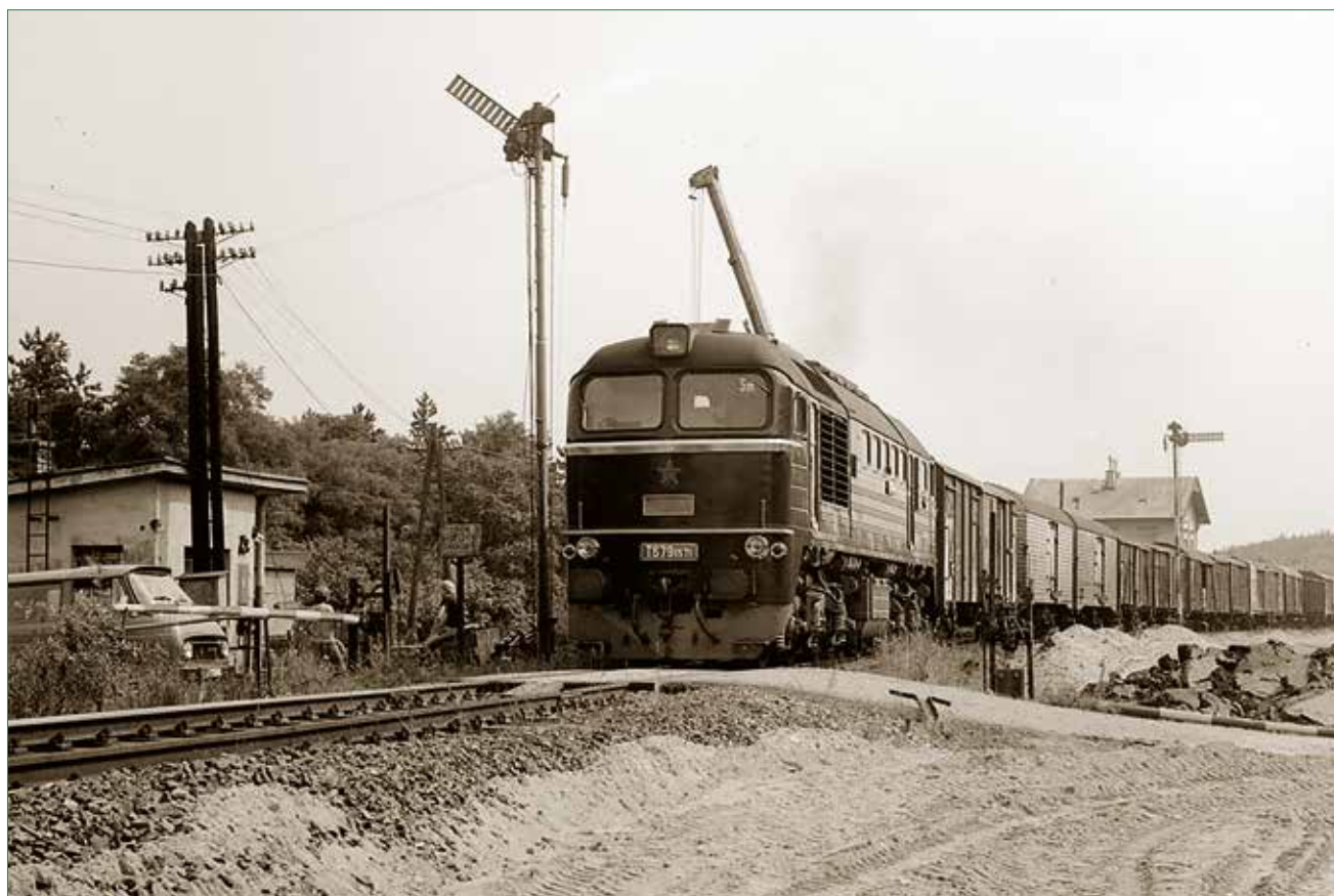
Průběžný nákladní vlak vedený lokomotivou T679.1571 u hlásky Praha-Stodůlky, probíhají stavební práce na budoucí výhybně, foto Petr Ovsenák 9. 8. 1983
