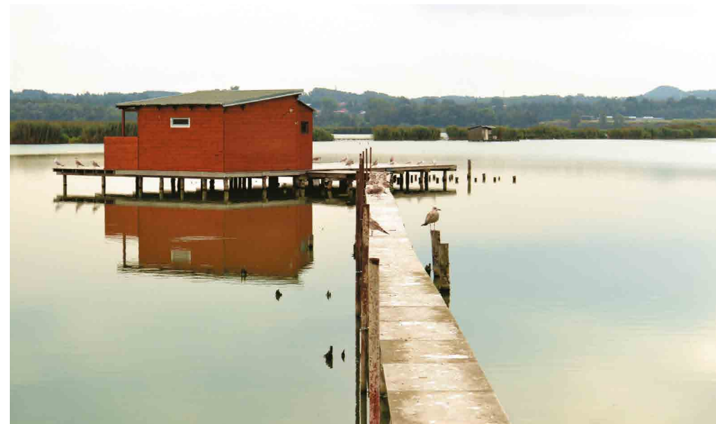
↑ Heřmanický rybník a jeho rybářské chaty vystavěné na kůlech z lešnářských trubek. K chatám vedou dřevěné lávky. V pozadí vpravo halda Trojice/Ema na Slezské Ostravě
